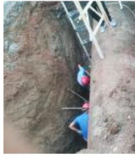
施工现场繁忙景象。
