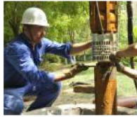
维修班成员正在抢修设备。
